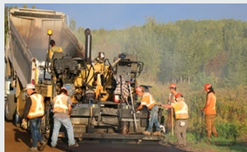
Figure 3. FPInnovations : Essais d'asphalte modifiée à la lignine sur des segments de route
